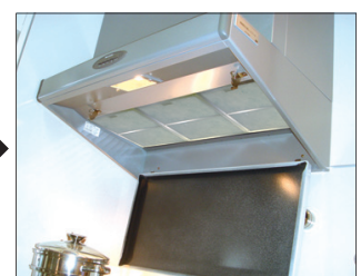
整流板をはずして取付します。
